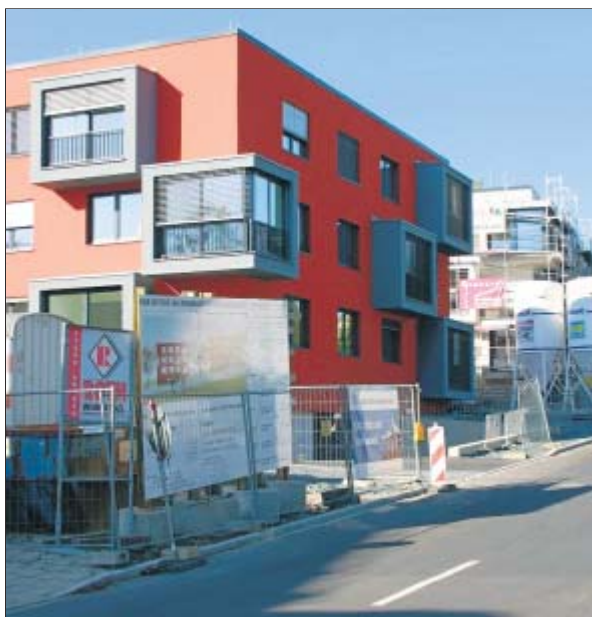
Die Passivhäuser an der Sedanstraße. Eines ist bereits fertig gestellt und schon bezogen.
