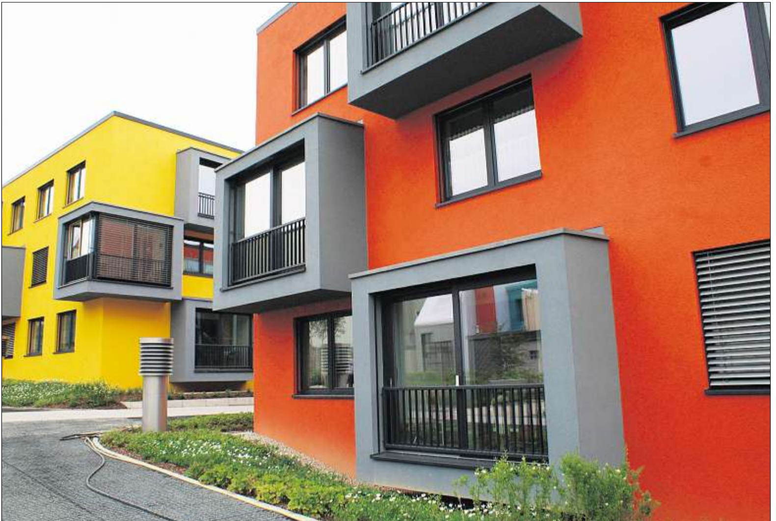
Eins rot, eins gelb: die Passivhaus-Wohnanlage in der Sedanstraße in Selb.
