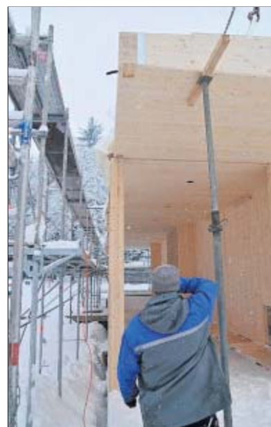
Schnee und Nässe behindern die Arbeiten am Jochen-Klepper-Haus.
