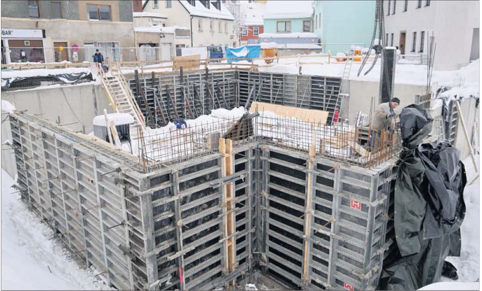
Auch am neuen Jugendhotel und Jugendhaus in der Innenstadt wird noch kräftig gearbeitet. Allerdings wird auch diese Baustelle, sobald die Schalung der Kellerußenwand entfernt ist, erst einmal „dicht“ gemacht. Sobald das Wetter passt, soll es weitergehen. Fotos: Miedl
