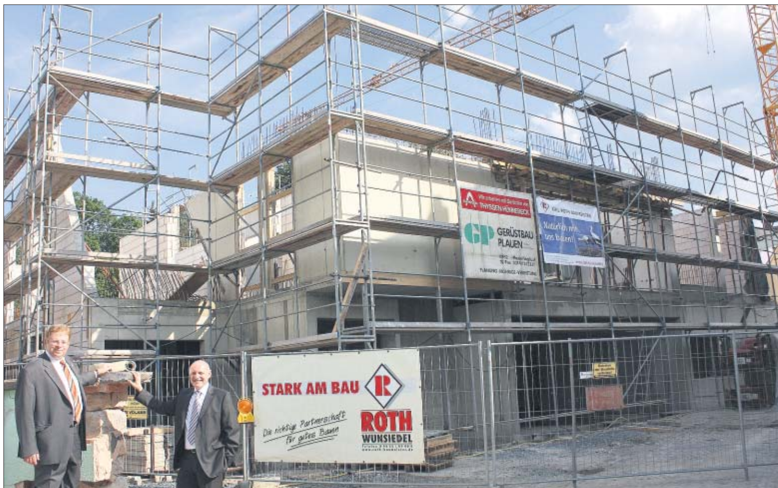
Mit einer Fertigstellung Ende 2012 rechnen Oberbürgermeister Wolfgang Kreil und Bauamtsleiter Helmut Resch beim neuen Jugendzentrum mit Jugendhotel.
