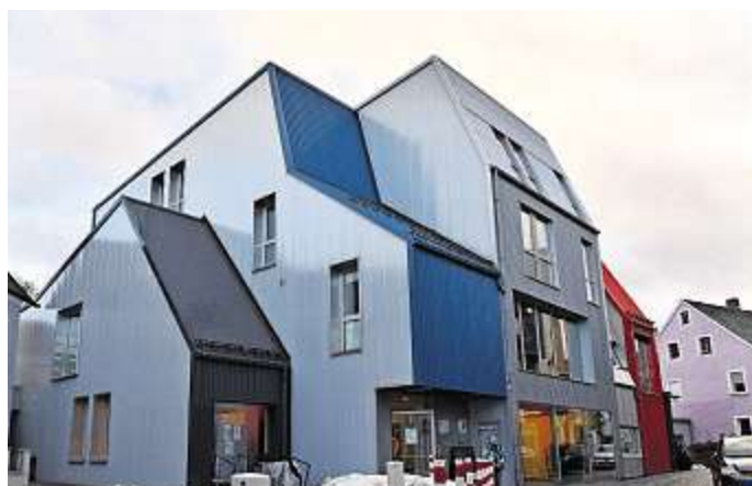
Einzelne Elemente verbinden sich beim Fam- und Jam-Gebäude in der Karl-Marx-Straße immer wieder neu.
