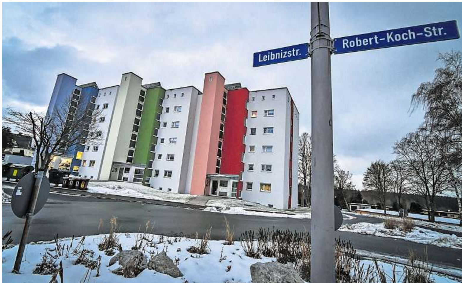
Von Grund auf saniert hat die Selbwerk GmbH die Wohnanlage Leibnizstraße.
