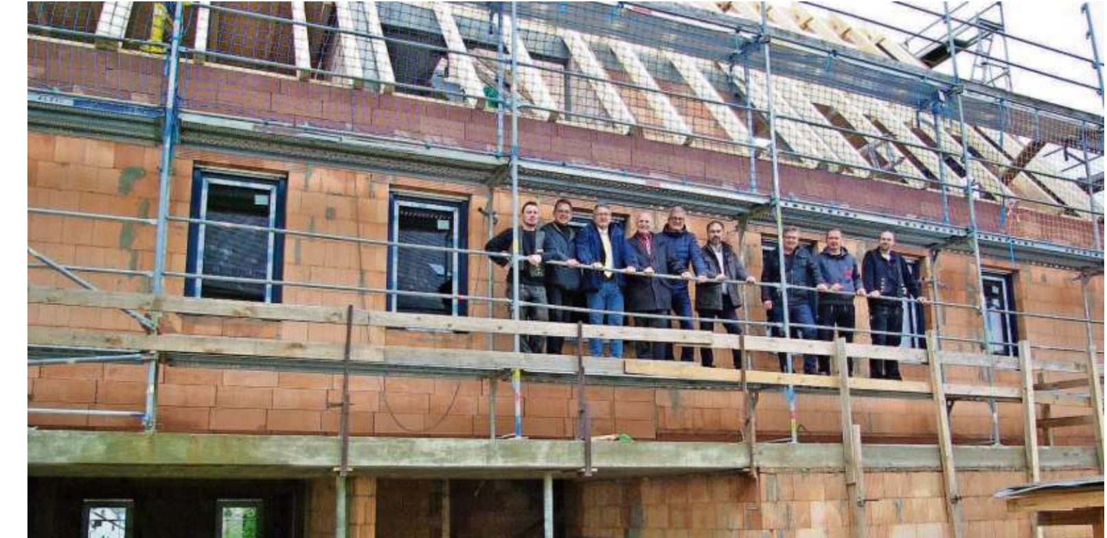
Der Rathaus-Rohbau in Höchstadt steht. Das feierte Bürgermeister Gerald Bauer (Sechster von links) mit seinen Stellvertretern, stellvertretendem Landrat Roland Schöffel (Dritter von links) Helmut Resch und Günther Wirth vom Selbwerk (Vierter und Siebter von links) und den Vertretern der am Bau beteiligten Firmen. Foto: Gerd Pöhlmann
