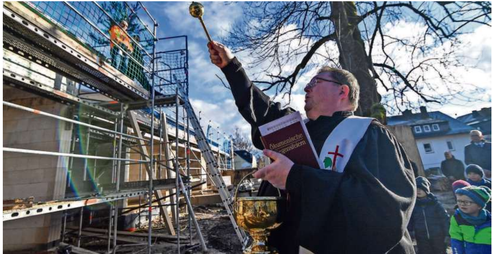
Die Stadt Selb baut einen neuen Kindergarten in Erkersreuth. Pfarrer Dr. Jürgen Henkel spendete dem Bau den kirchlichen Segen.
