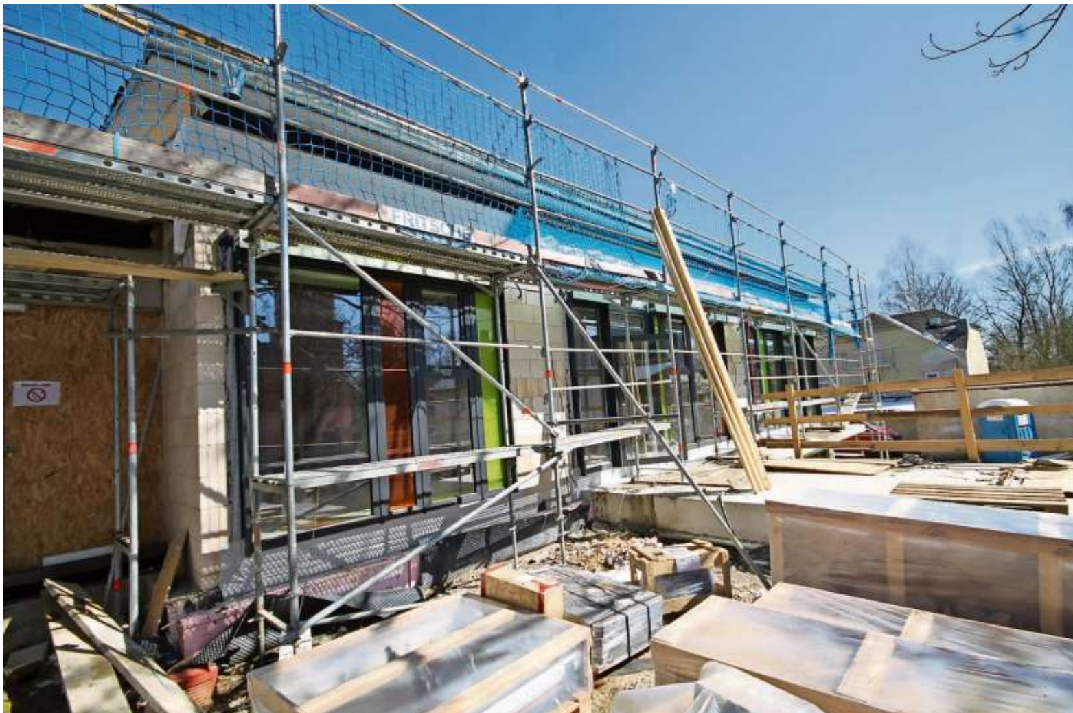
Die Arbeiten am Kindergarten Erkersreuth gehen trotz der Corona-Krise zügig voran.
