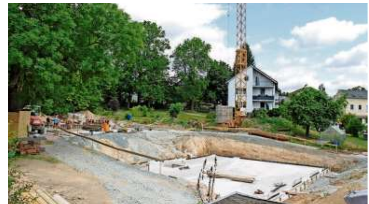
Ein wichtiger Schritt im Juli 2019: Der neue Kindergarten erhält sein stabiles Fundament.
