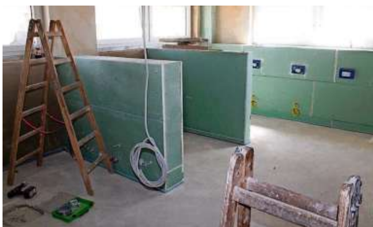
Hier entstehen derzeit die neuen Sanitäranlagen. Diese sind überaus großzügig konzipiert.
